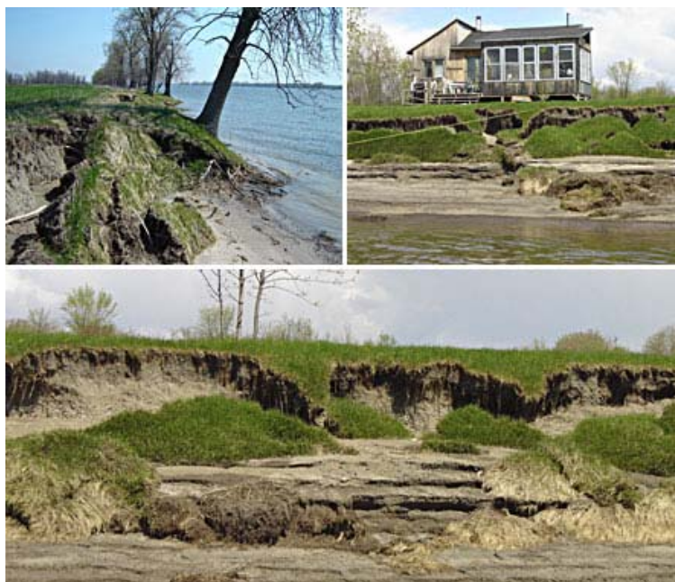
Figure 8. Dégradation et érosion des rives.
